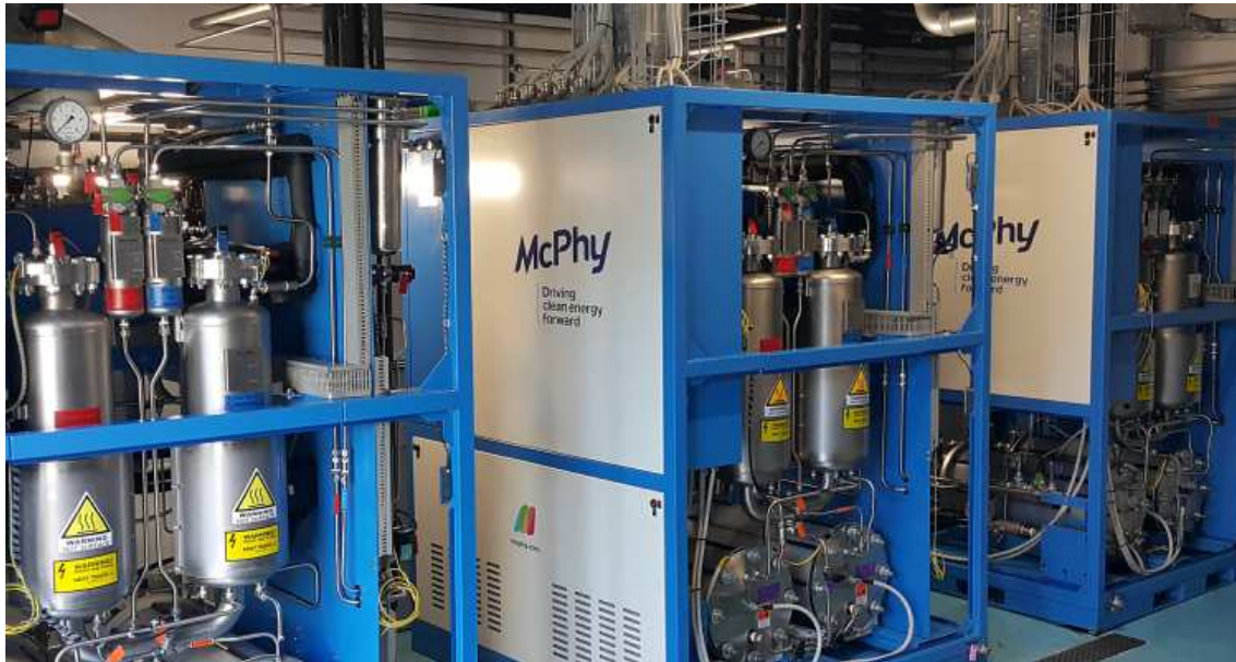
FIGURE 14 – Un électrolyseur de la société MacPhy
